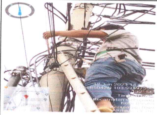
PEMASANGAN FIBER OPTIK
