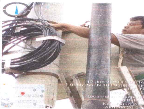
PEMASANGAN FIBER OPTIK
