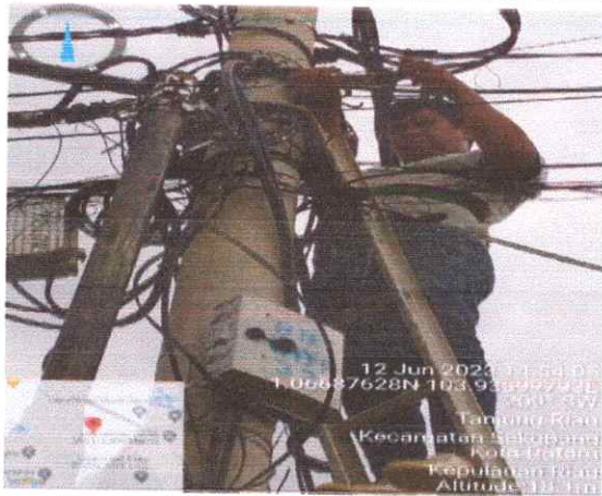
PEMASANGAN KABEL FO
