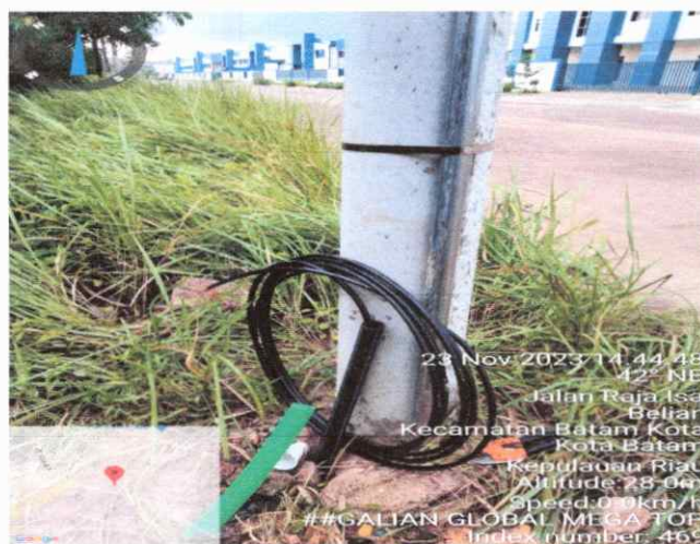
Proses Tarik Kabel Ke Sub ODP
