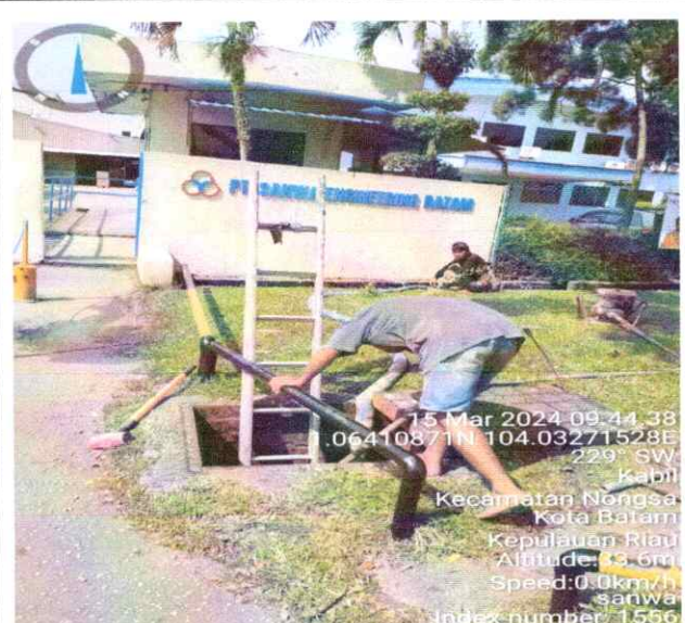
Buka Mainhole dan pengeringan jln beringin
