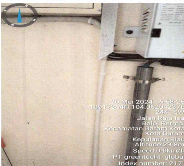
Jalur kabel greentech
