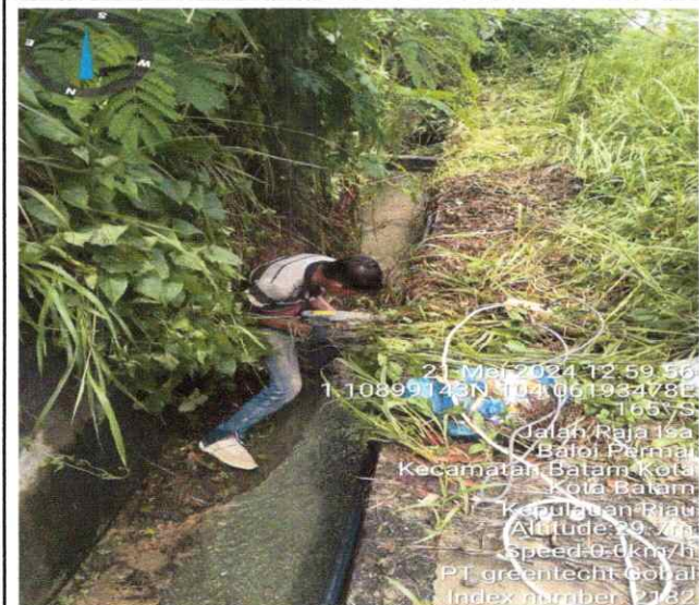
PEMASANGAN KLEM HDPE
