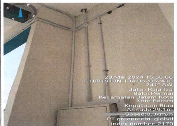
JALUR KABEL GREENTECH
