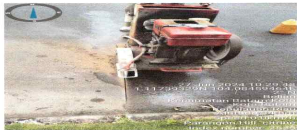
PEMOTONGAN ASPAL
