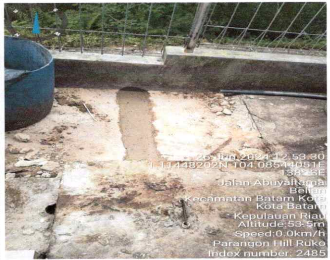
BOBOK DAN PERBAIKAN BETON
