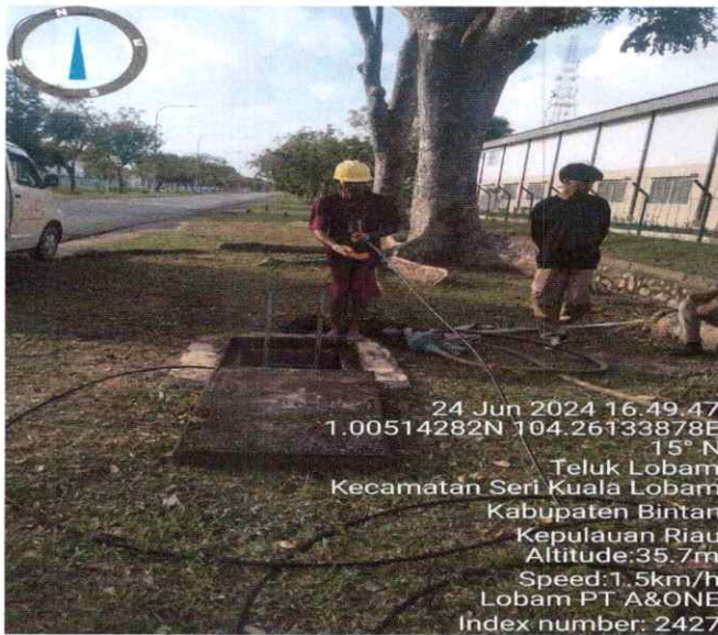
TAIK KABEL DI MAINHOLE
