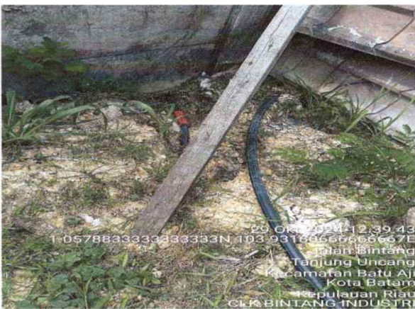
PENARIKAN KABEL FO
