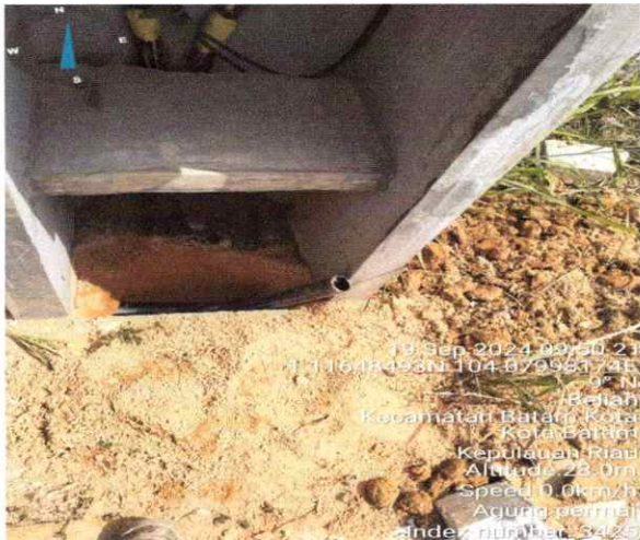
BOBOK BETON KWH JALUR KABEL
