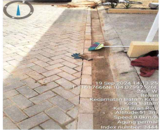
BONGKAR PASANG PAVING BLOK
