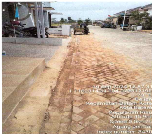
PEMBERSIHAN LOKASI KERJA
