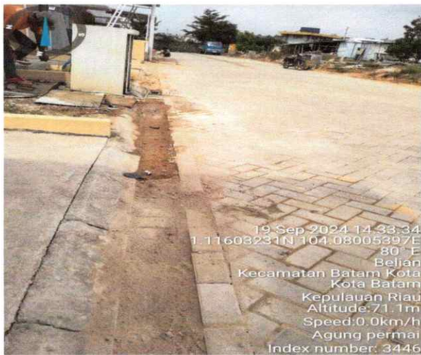
BONGKAR PASANG PAVING BLOK
