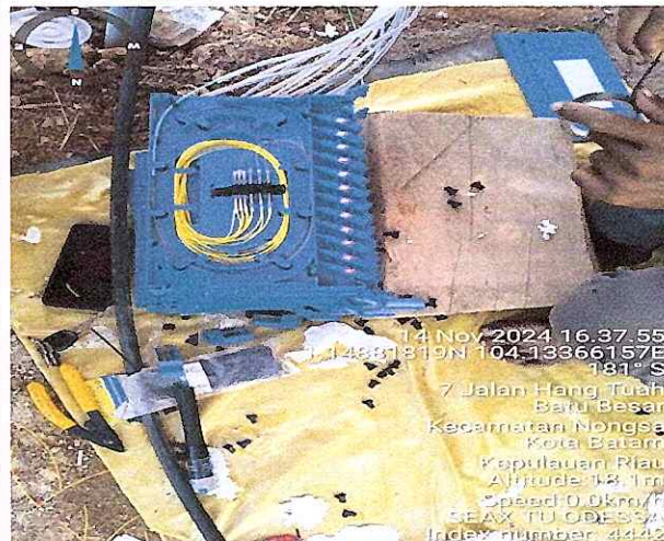
TERMINASI ODC SPLICING
