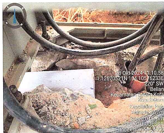
BOBOK JALUR KABEL ANTAR ODC
